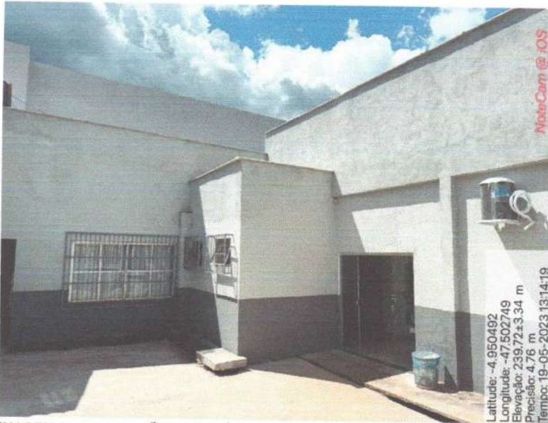
IMAGEM 10: ADAPTAÇÕES NO PRÉDIO JÁ EXISTENTE DA CÂMARA MUNICIPAL, CONSTRUÇÃO DE PLATIBANDA.
