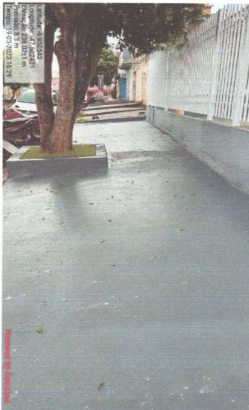
IMAGEM 02: PINTURA DAS CALÇADAS EXTERNAS.
